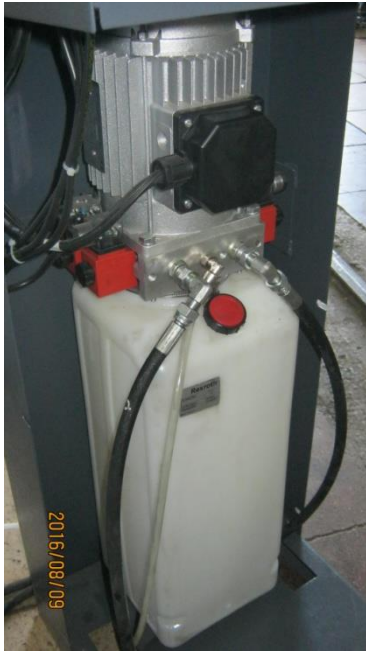
۶- نصب مجدد شیر برقی EDT
