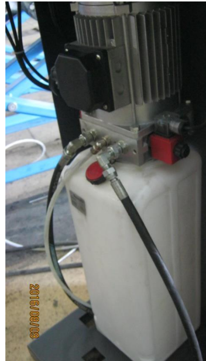
۹- نصب مجدد شیر برقی EOP
