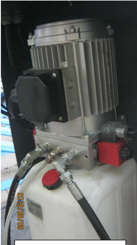
۱۰- نصب مجدد شلنگ تخلیه روغن
