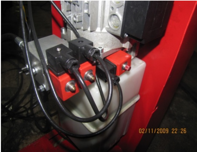
6- نصب مجدد شیر برقی EDT
