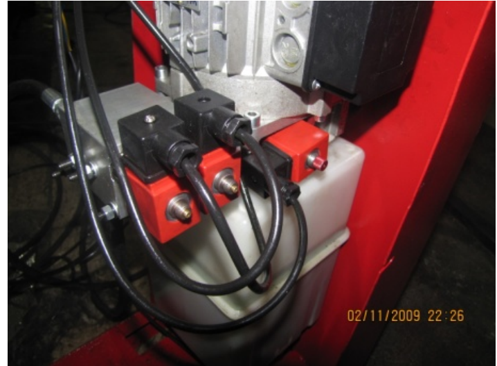
9- نصب مجدد شیر برقی EOP
