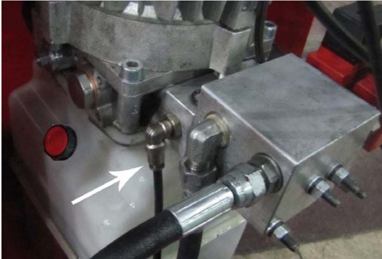
10- نصب مجدد شلنگ تخلیه روغن
